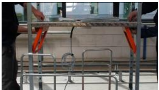
Verwijder de bouten voor het hekwerk
