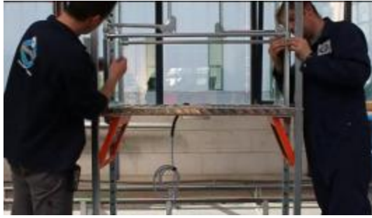
Plaats de liggers van het hekwerk
