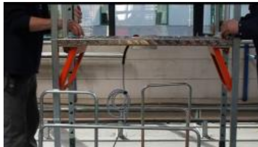
plaats de palen voor het hekwerk
