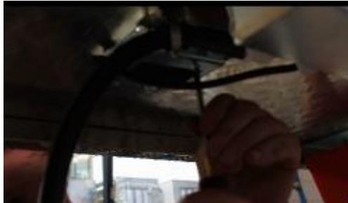
bevestig de bouten van de voetschakelaar
