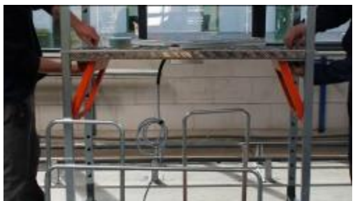
Verwijder de bouten voor het hekwerk
