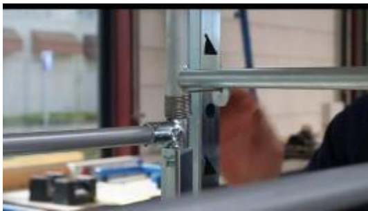
Установите пружину защитных перил
