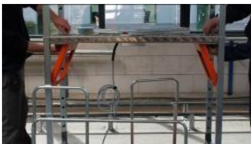
Снимите болты для перил
