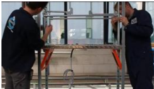
Coloque las barras horizontales de la barandilla
