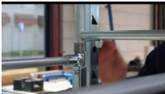
Coloque el muelle de la barandilla
