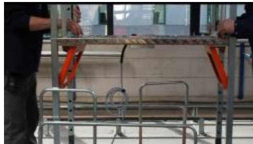
coloque las barras delante de la barandilla
