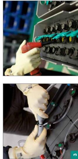
Falls nötig füllen sie demineralisiertes Wasser nach. Vermeiden sie unbedingt eine Überfüllung der Zellen.
