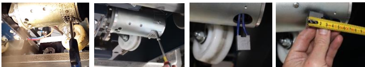
Figuur 9.4; Koolborstels motor inspecteren
