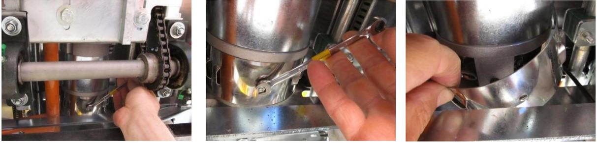
Entfernen Sie die Bürstenabdeckung mit dem 8mm Schraubenschlüssel.
