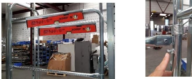
Placez la glissière supérieure de façon droite et serrez-la avec le boulon indiqué.
