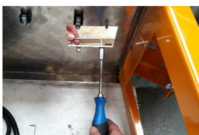
Apoggiare una piattaforma (Pacchetto B) su un cartone e svitare i bulloni.
